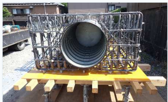
施工性確認試験
